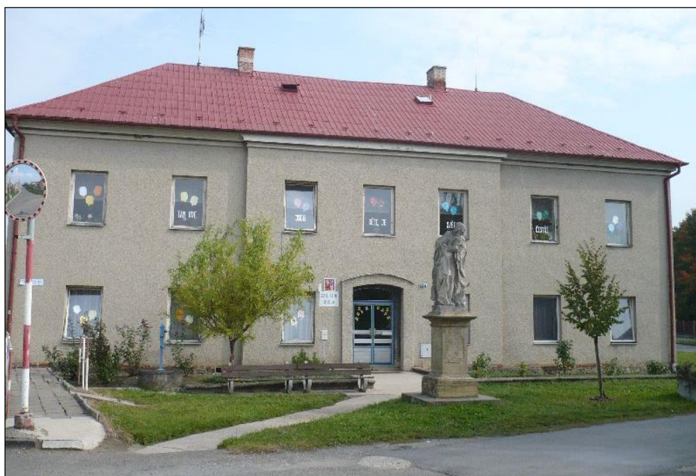
Budova prvního stupně (1. – 3. ročník)
