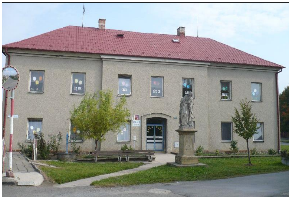
Budova prvního stupně (1. – 3. ročník)
