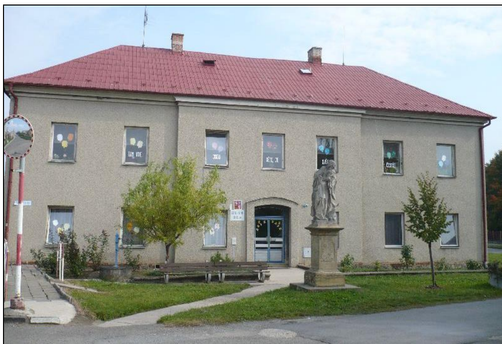
Budova prvního stupně (1. – 4. ročník)
